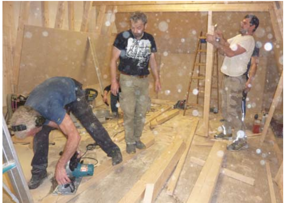
Was auf dem Foto wie ein Indoor-Schneesturm wirkt, ist die enorme Staubbelastung durch die Holzbearbeitung.
