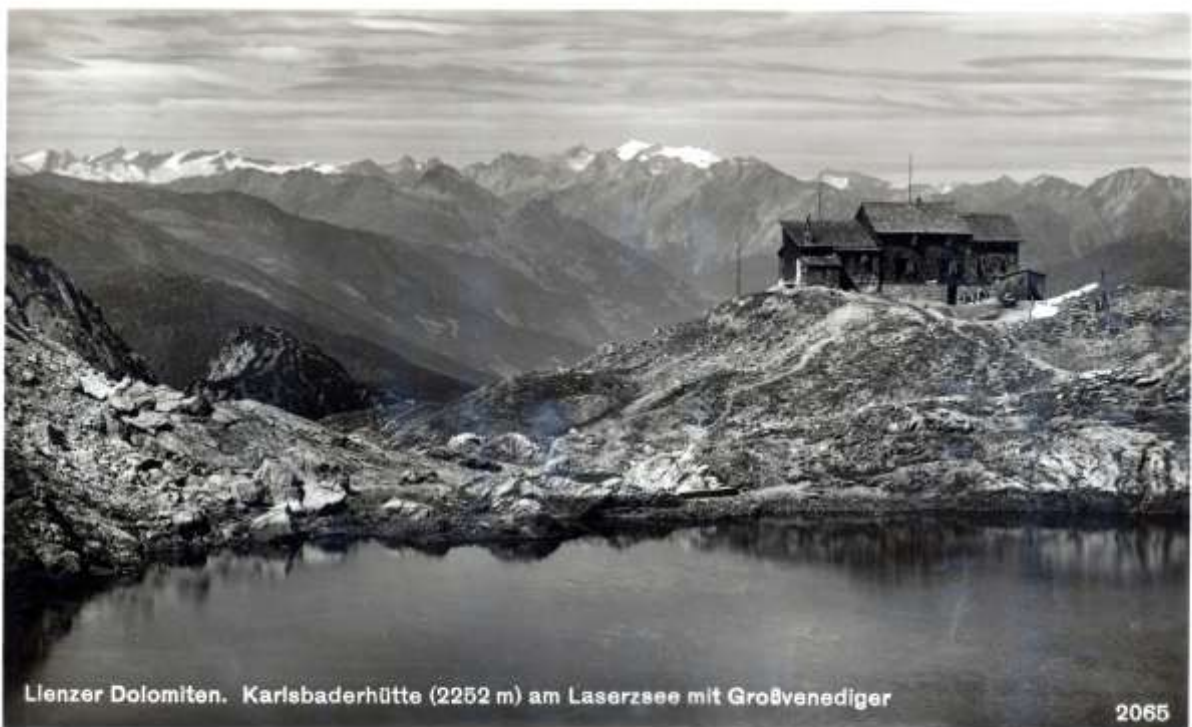
Nach dem II. Umbau (1923)
