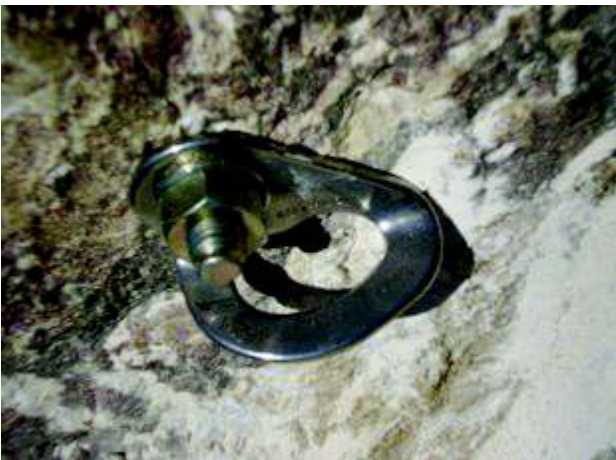
So halten diese vorbildlich gesetzte Bohrhaken jahrzehnte lang
