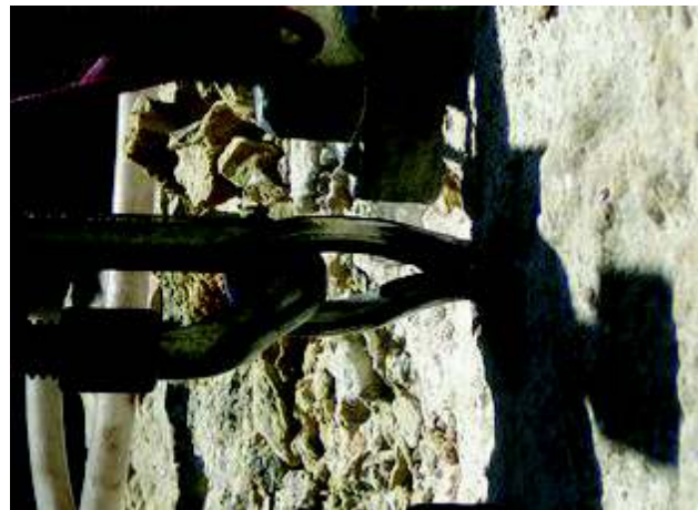
So halten diese vorbildlich gesetzte Bohrhaken jahrzehnte lang
