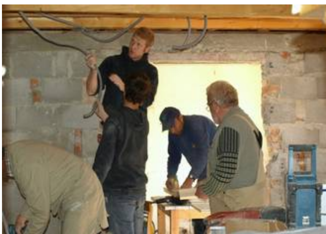
Der gesamte Küchenbereich wurde 2009 umgebaut und wird 2010 neu eingerichtet.
