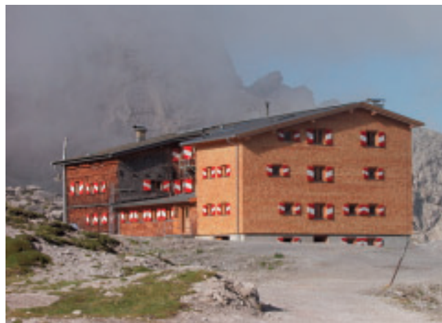
Das neue Aussehen der Karlsbader Hütte – ein gelungener Anbau - Nord-Ost-Ansicht
